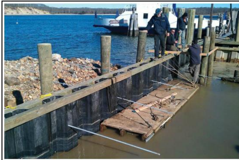
6. ábra PURLoc hullámtörő gát építés közben
