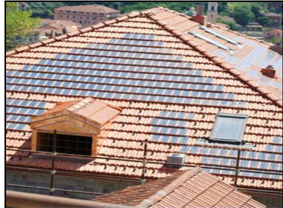
2. ábra Wegalux műanyag cserepekbe ágyazott napelemek egy hagyományos cseréptetőn
