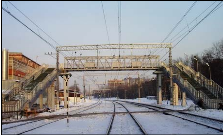
3. ábra Üvegszál-as poliszterelemekből készített vasúti felüljáró Moszkvában
