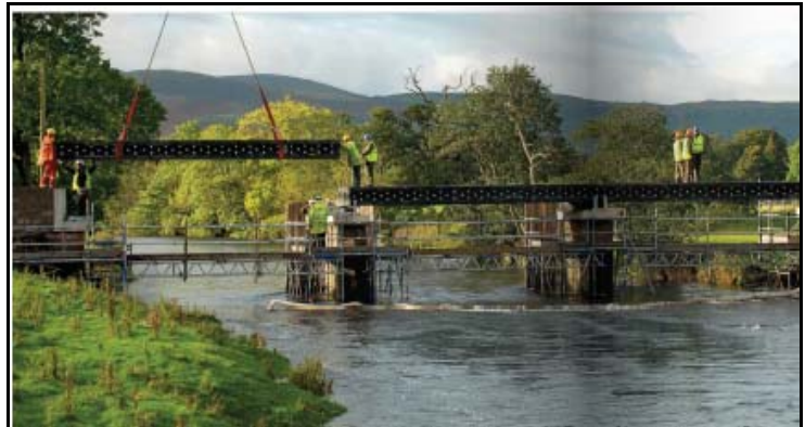
5. ábra A Skóciában hőre lágyuló műanyagok hulladékából gyártott elemekből 4 nap alatt összeszerelt híd építés közben
