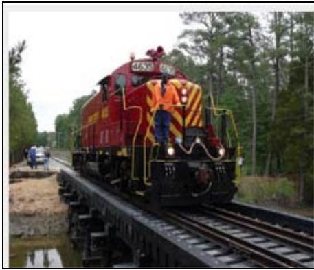
4. ábra A FRPP/HD-PE kompaundból felépített egyik vasúti híd Eustisben
