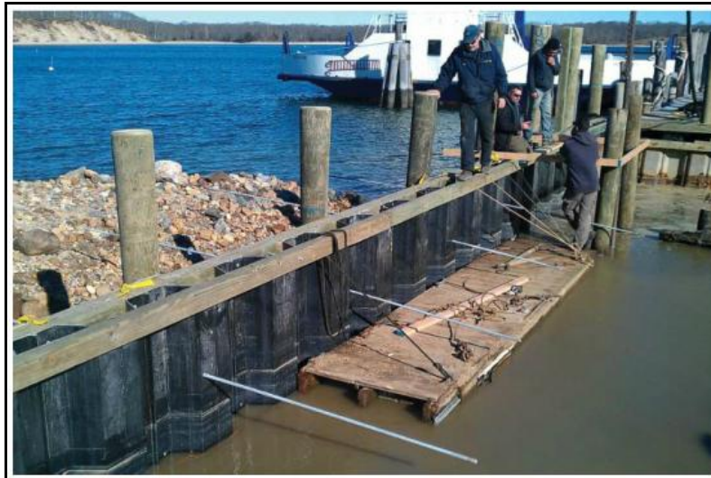
6. ábra PURLoc hullámtörő gát építés közben
