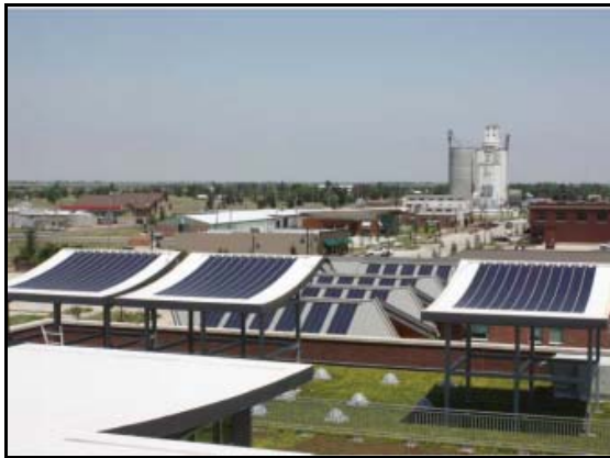
1. ábra A greensburgi (Kansas) Kiowa közösségi ház (Kiowa county common) Extreme TPO membránnal felújított tetőszerkezete a tornádó pusztításai után
