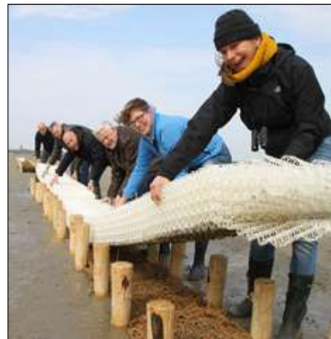
6. ábra Vízben lebomló kagylónevelő rácsok telepítése a tengerbe
