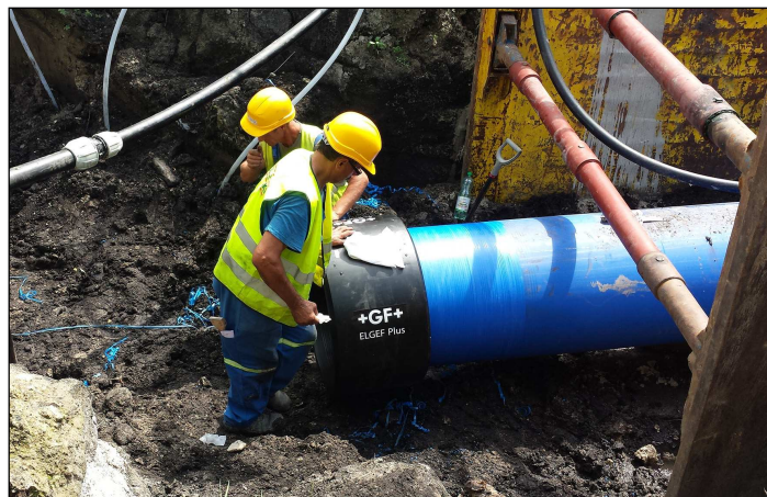
3. ábra Lengyel szerelők egy kötőidomot szerelnek a PE cső végére
